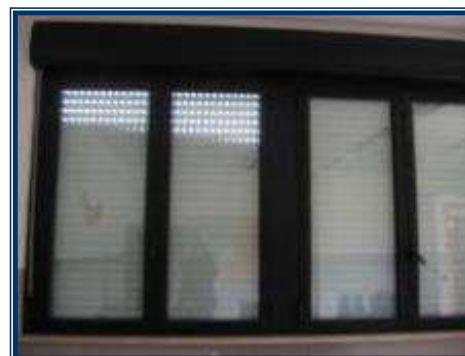
infissi esterni con "ante a battente" al piano primo
