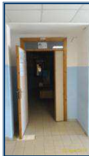
Porta interna di accesso alle aule al piano terra
