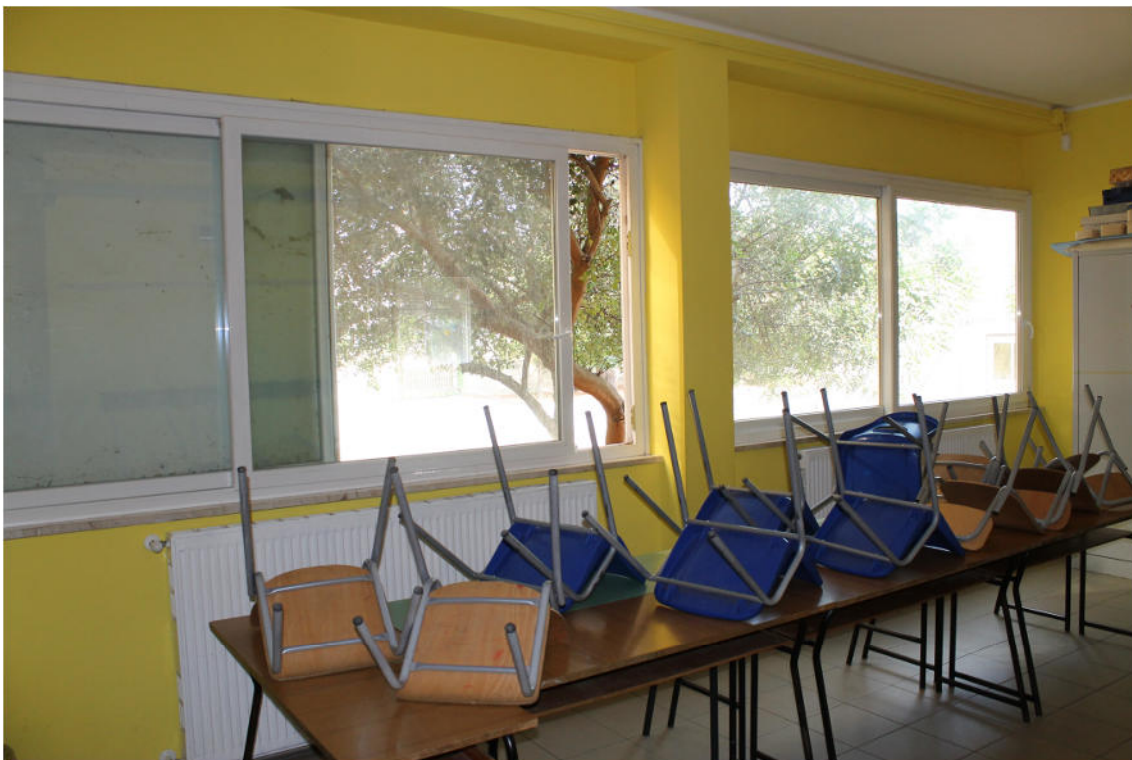
Foto 15: dettaglio del corridoio centrale piano terra interessato alla realizzazione di una nuova uscita di sicurezza (a sinistra), previa rimozione infisso e radiatore
