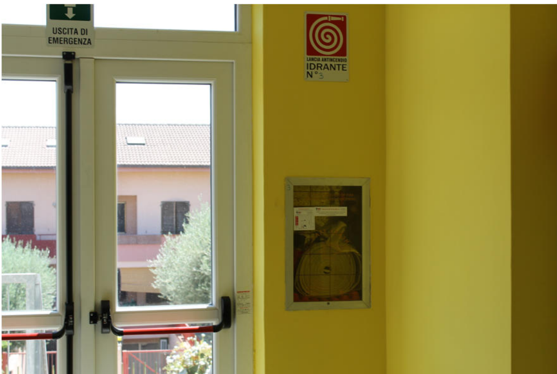
Foto 2: particolare derivazione nuova linea da idrante esistente incassato
