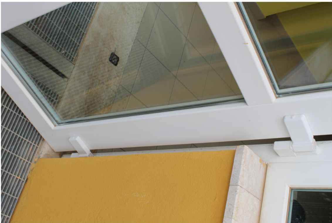
Foto 17: parte di muratura da tagliare onde consentire l'apertura completa dell'infisso lato scala antincendio
