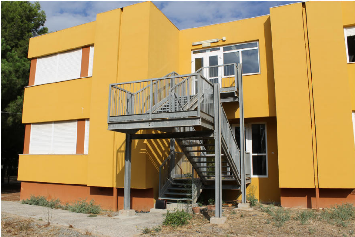
Foto 11: vista da terra (dall'ingresso laterale) del perimetro del lastrico solare su cui installare i parapetti metallici
