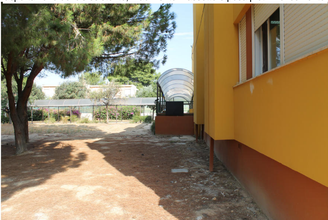
Foto 21: tunnel anteriore lato ingresso principale con rampa (vista laterale).
