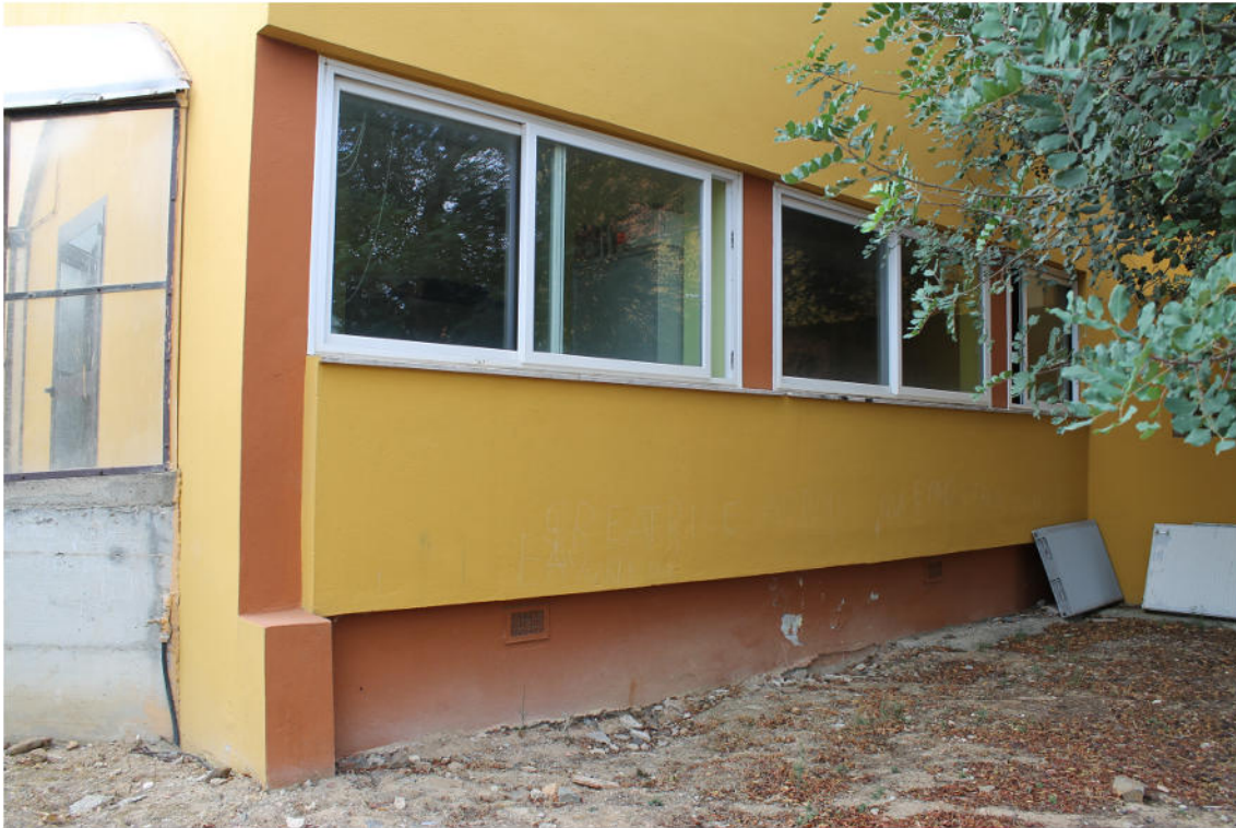
Foto 14: vista esterna del lato del corridoio centrale al piano terra interessato alla realizzazione di una nuova uscita di sicurezza, con realizzazione di scala esterna
