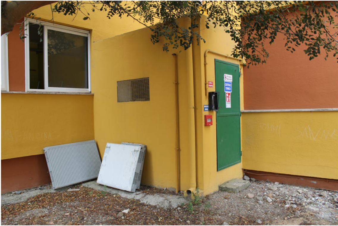
Foto 6: esterno centrale termica
