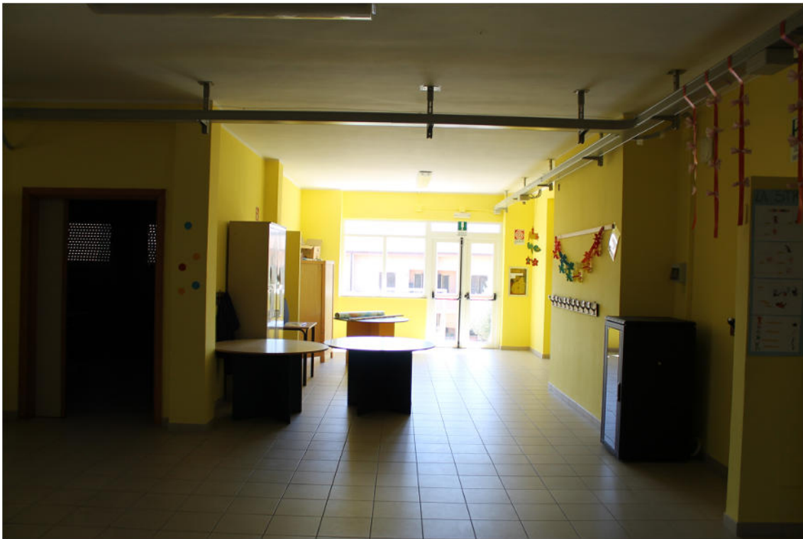
Foto 1: punto di derivazione linea idrante da quello esistente
