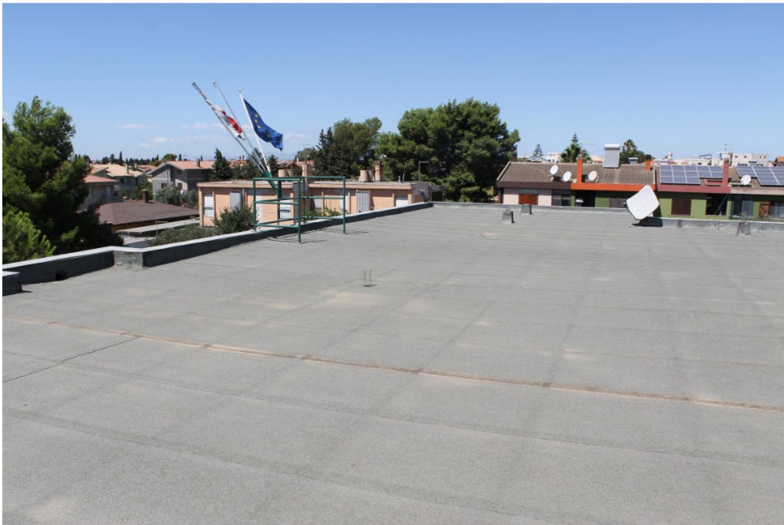
Foto 7: lastrico solare su cui installare i parapetti metallici
