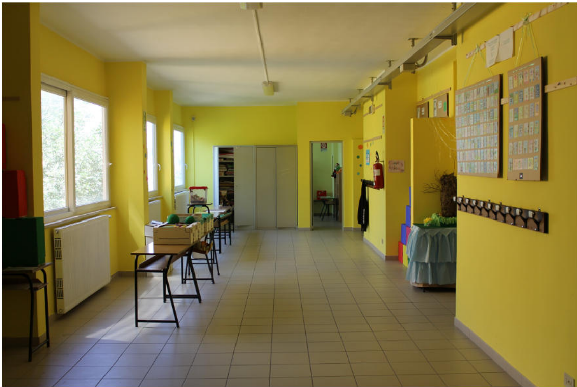
Foto 12: corridoio centrale piano terra interessato alla realizzazione di una nuova uscita di sicurezza (a sinistra), previa rimozione infisso e radiatore
