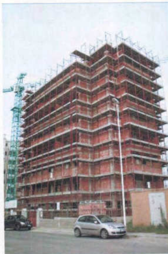
Nuova costruzione strada B
