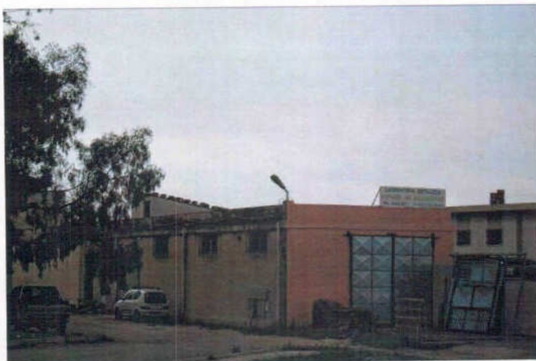
Carpenteria fine strada L
