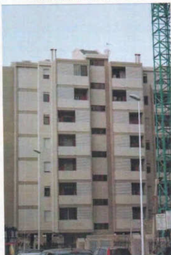
Costruzione presso strada D
